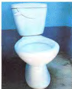
Foto7: sustitución de inodoro
