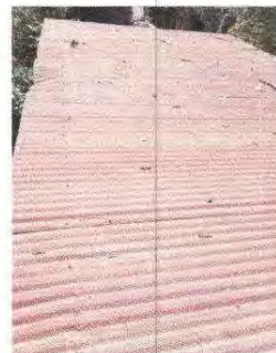
Foto2: Sustrucción de lámina por lámina troquelada aluzinc calibre 26
