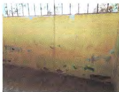
Foto 6: Pintura en muros exteriores e interiores
