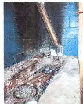
Foto 14: Sustrución de chimenea de concreto
