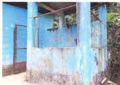
Foto 9: Mantenimiento a barandas de metal
