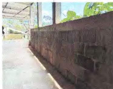
Foto 16: Repello en muros
