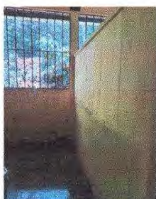
Foto 17: Sustrución de cancel de madera por muro de block
