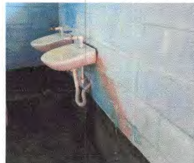
Foto 8: Sustitución de lavamanos
