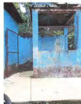
Foto 10: Mantenimiento a barandas de metal
