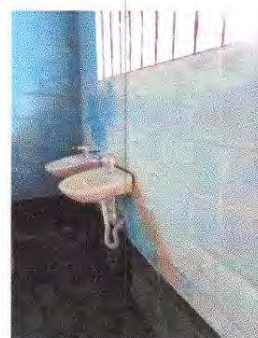
Foto 12: Instalación de top de lavamanos
