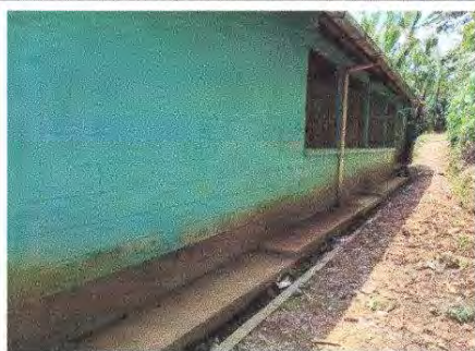
Foto 5: Pintura en muros exteriores e interiores
