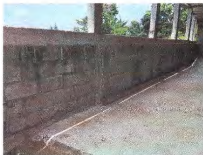
Foto15: Repello en muros
